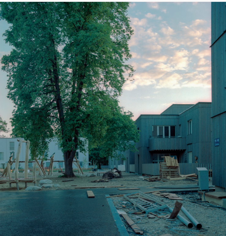
Innenhof Baugemeinschaft München und gemeinsam größer
