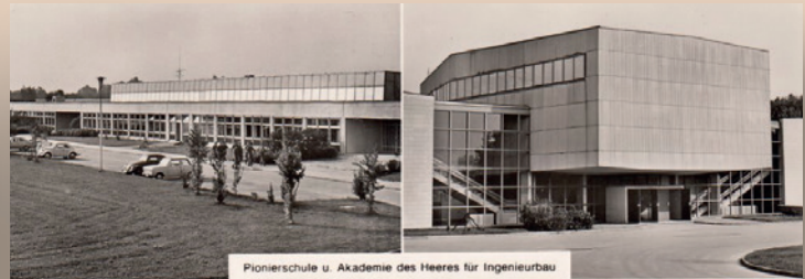
Pionierschule u. Akademie des Heeres für Ingenieurbau MÜNCHEN Prinz-Eugen-Kaserne
