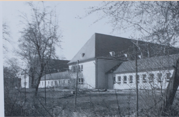
Kasernenbauten im Südosten des Areals der ehemaligen Prinz-Eugen-Kaserne vor ihrem Abriss 2009
