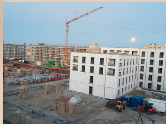
Ganz links Blick auf die Baustelle des Senioren- zentrums der IKG 2021
